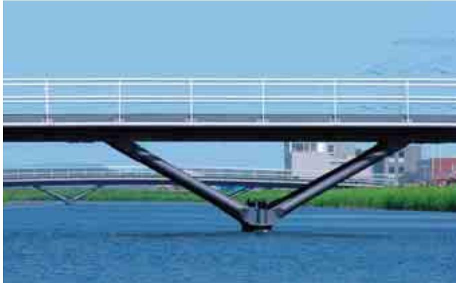
Alle Brücken basieren auf einem modularen System aus V-förmigen Stützenpaaren.
