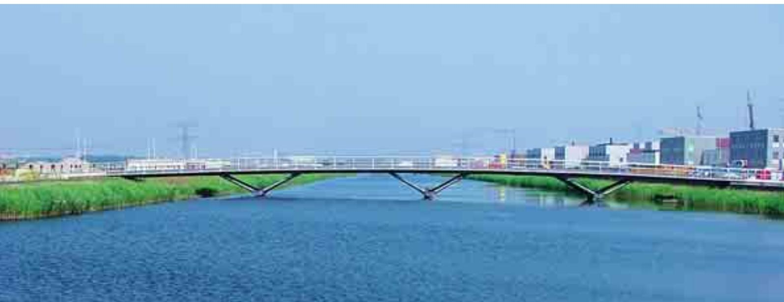
vorgesehen. Die Beleuchtung der Wege ist in die Handläufe integriert, während die vorgeschriebenen Positionsleuchten auf den Fusspunkten der Brückensützen befestigt sind. Die Stahlkonstruktion der Brücke wird, vorgefertigt und beschichtet, in Einzelteilen an den Bauplatz transportiert und vor Ort verschraubt. Nachträgliches Schweißen entfällt, da es den Korrosionsschutz beschädigen würde.
