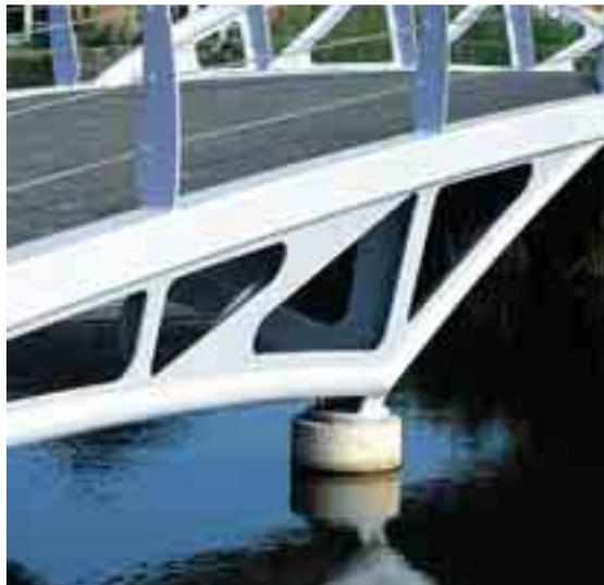
Das Zwischenaufleger ist um einige Meter aus der Mitte versetzt.
