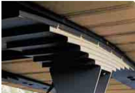
Au-dessus des piliers, des ressorts à lames forment une selle d'appui pour le tendeur continu.
