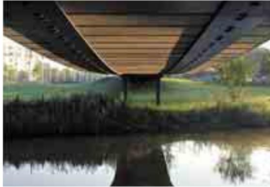
Les éléments en béton préfabriqués du revêtement sont boulonnés aux tendeurs en acier de construction à grain fin à résistance élevée.
