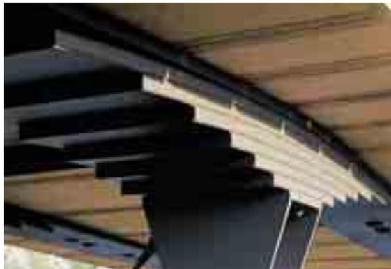
Über den Stützen bilden Blattfedern einen gerundeten Sattel für das durchlaufende Spannbänder.
