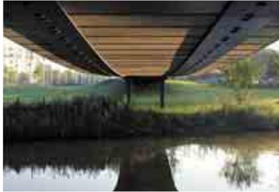
Die Betonfertigteile des Belags sind mit den Spannbändern aus hochfestem Feinkornbaustahl verschraubt.
