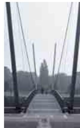
Werden die Mastspitzen nach aussen gekippt, hebt sich die Brücke in der Mitte um 10,60 m – im Normalzustand ist der «Buckel» 1,10 m hoch.
