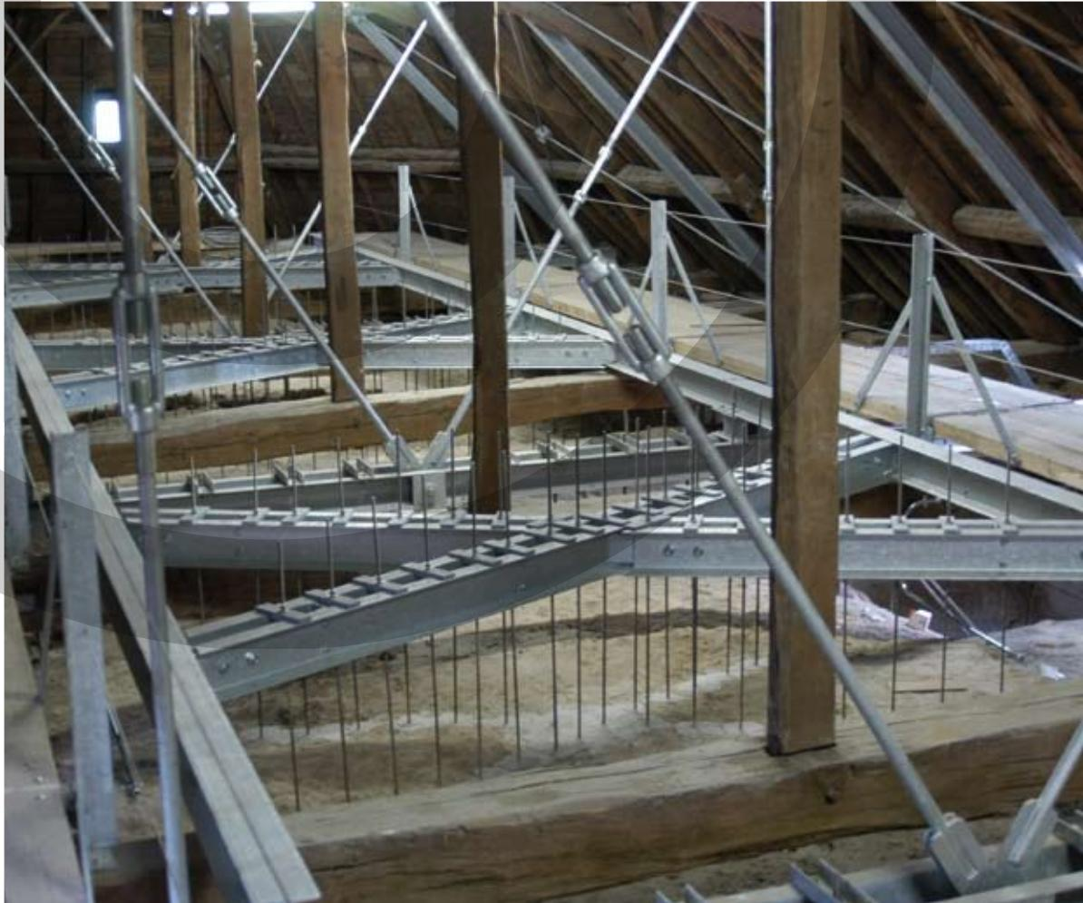
De geometrie van de metalen spanten kopieert de vorm van het bestaande eikenhouten gebinte en laat zich perfect in het geheel integreren. Daar de verbindingspunten tussen de verschillende elementen zo eenvoudig mogelijk dienden te zijn, werden de knooppunten voorzien van slechts één enkele bout met een diameter van 40 mm. Over het algemeen laat staal discrete profielen toe dan houten structuren. Op die manier bewaart het houten gebinte zijn overheersende rol.
