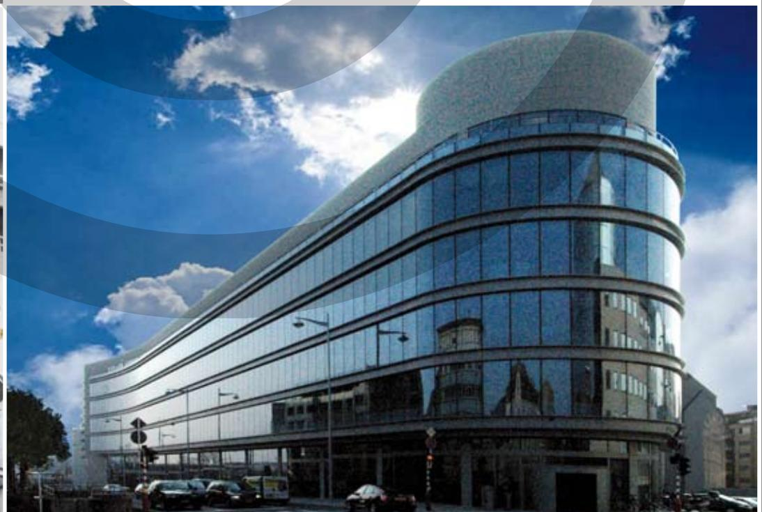
verdiepingen, brachten de ontwerpers ertoe te kiezen voor een gemengde structuur van staal en beton. Deze oplossing liet toe zich aan de bestaande structuren aan te passen en een aanzienlijke overbelasting te vermijden. De gemengde structuur werd gerealiseerd met behulp van raatliggers bekomen van warmgewalste IPE- of HE-profielen.
