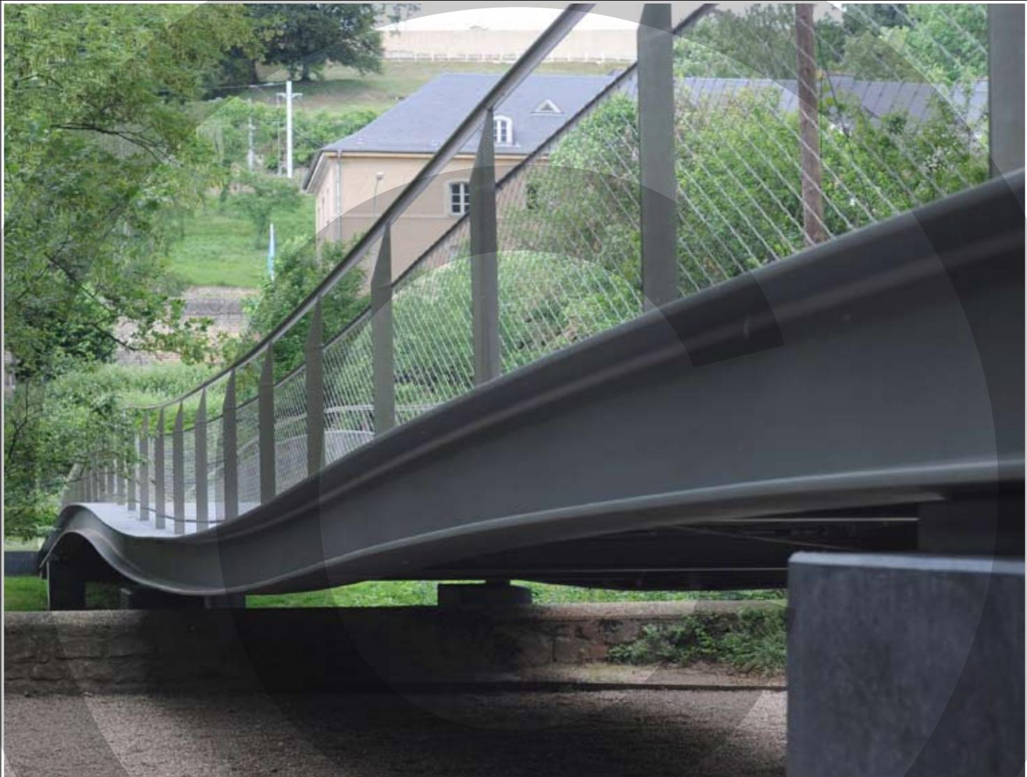
gebruikt met een tussenruimte van 4 m en een stabiliteitsverband en trekstangen M20 (10,9). De beplating bestrijkt een oppervlakte van 100 m<sup>2</sup> en is uitgevoerd in staalplaten van 40 x 200 cm bij een dikte van 5 mm. De gebruikte staalkwaliteit is S355 J2G3.
