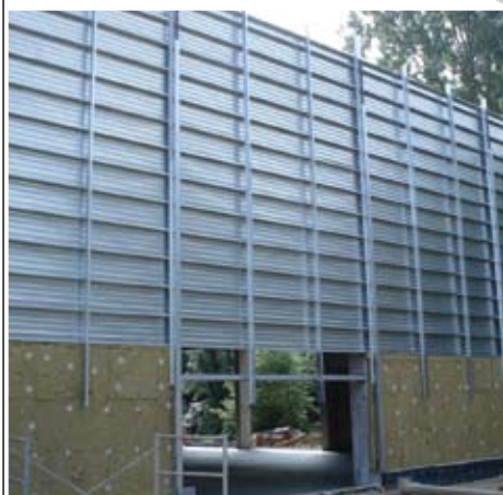
detaill van de stalen bardage_détail du bardage en acier
