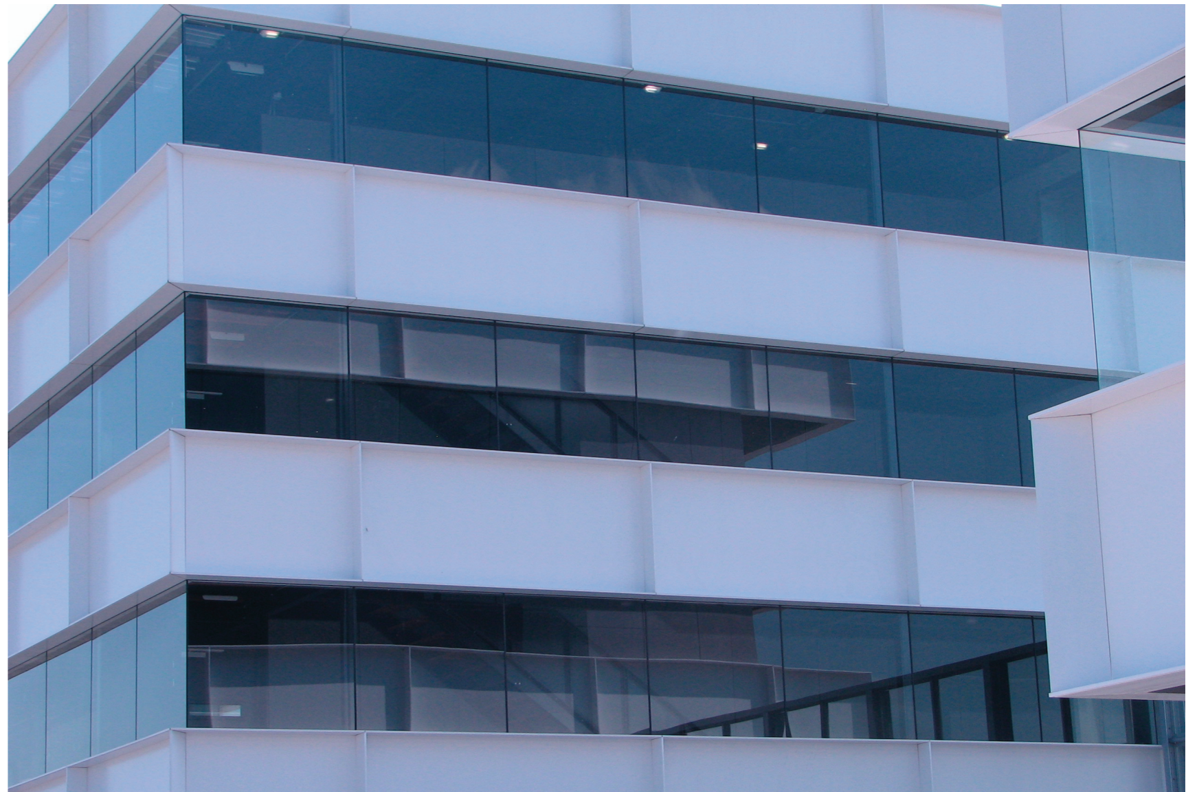
Foto: Gevel Westzijde
