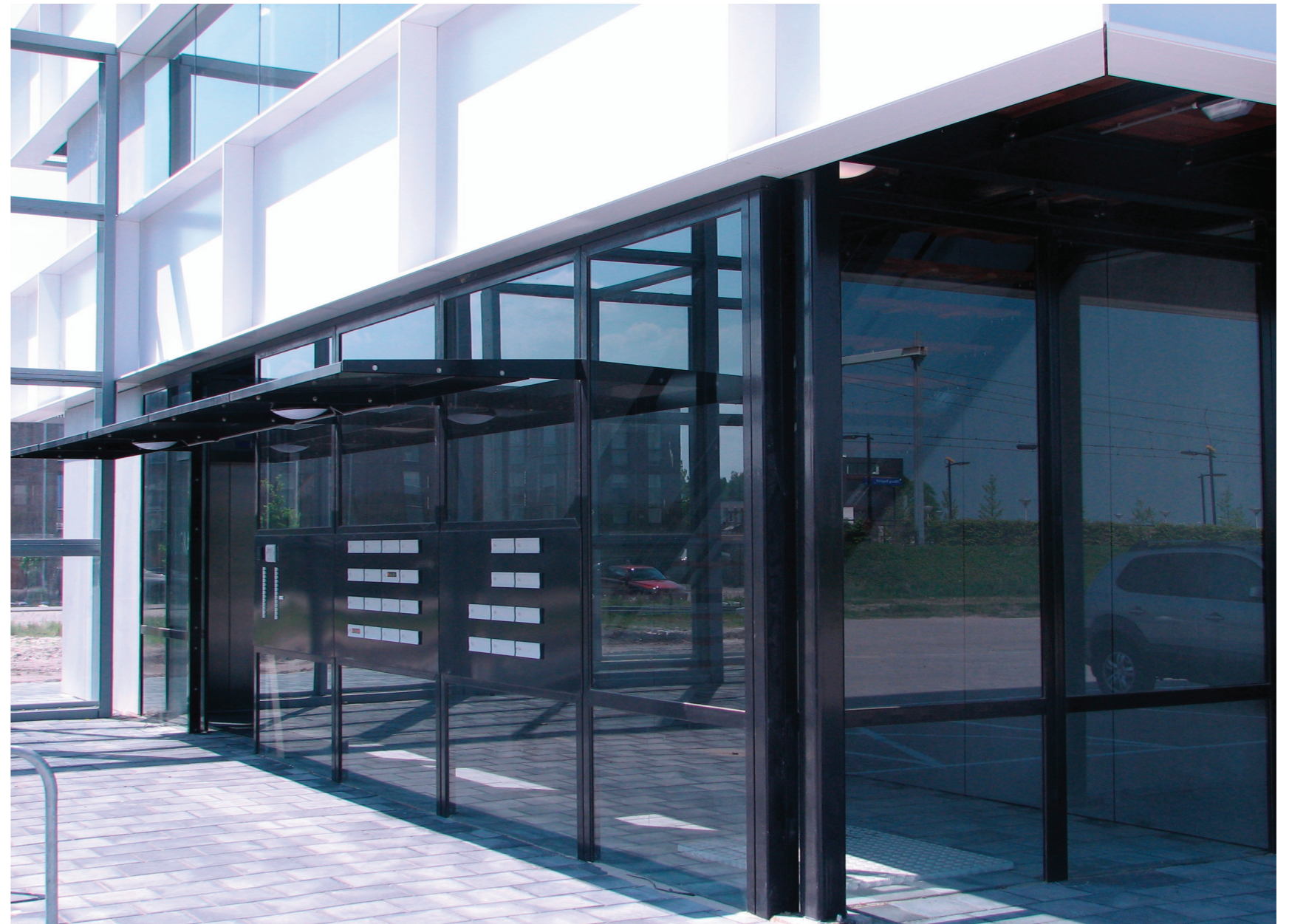
Foto: Entree met stalen luifel en samengestelde stalen hoekprofielen
