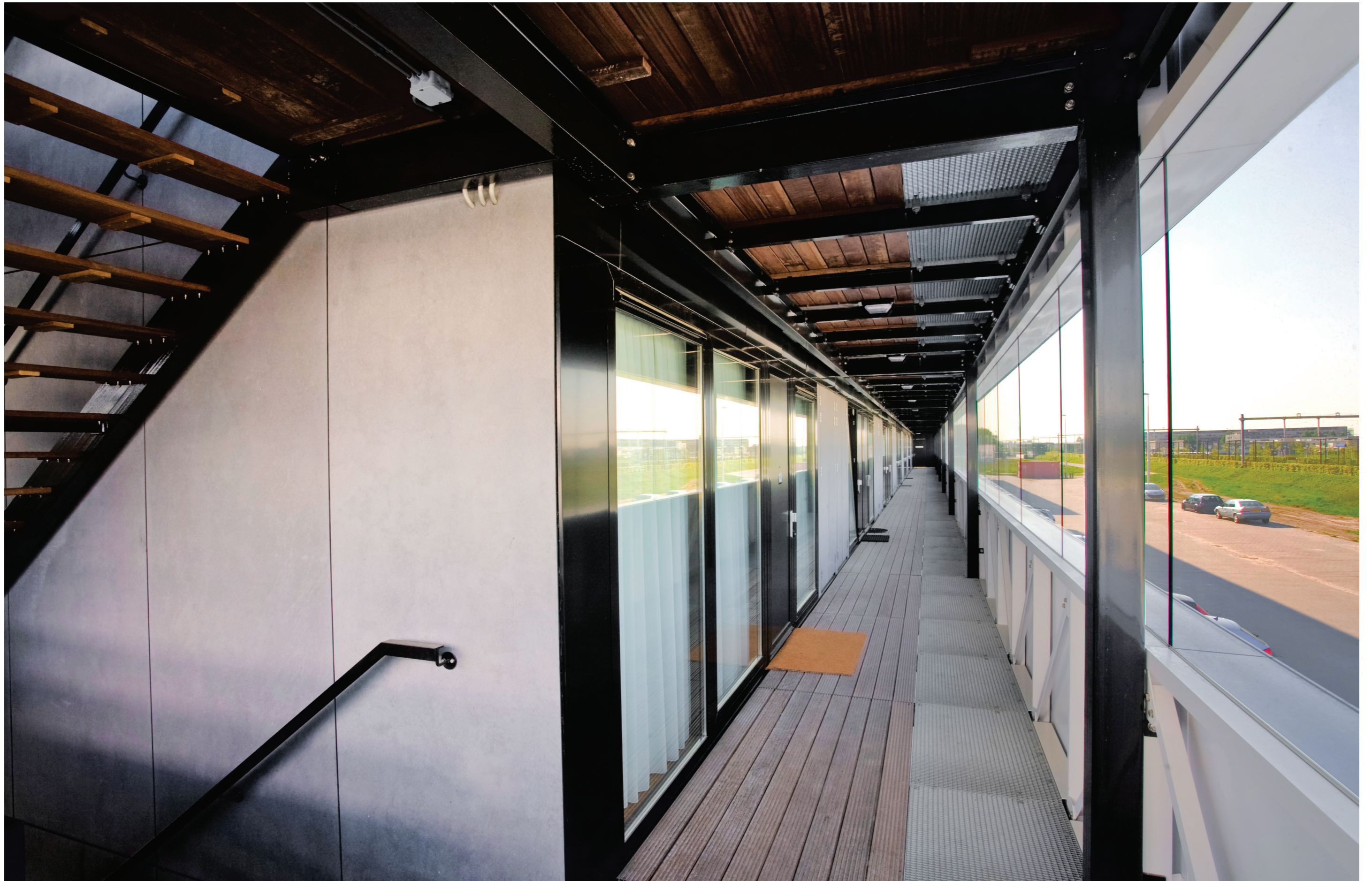
Foto: Persrooster vloer tbv ventilatie galerij
