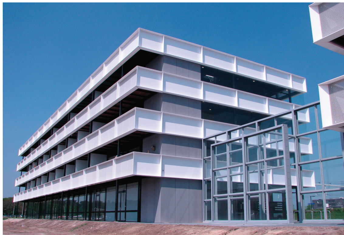
Foto: Gevel Noordzijde
