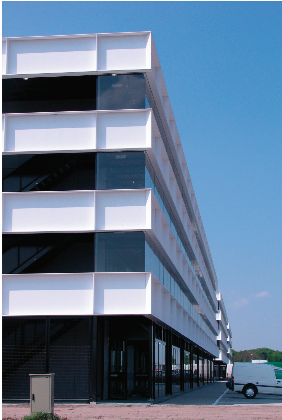
Foto: Gevel Noordzijde
