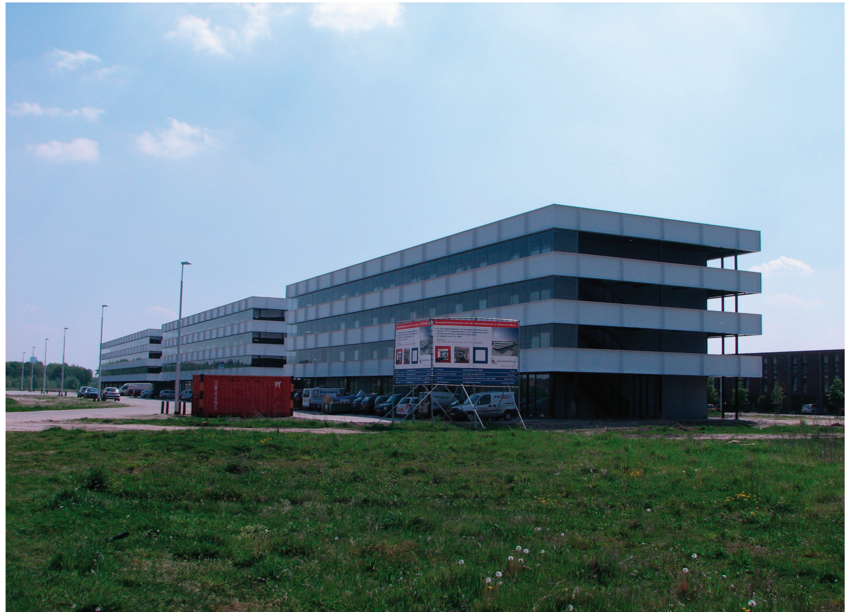
Foto: Gevel Noordzijde
