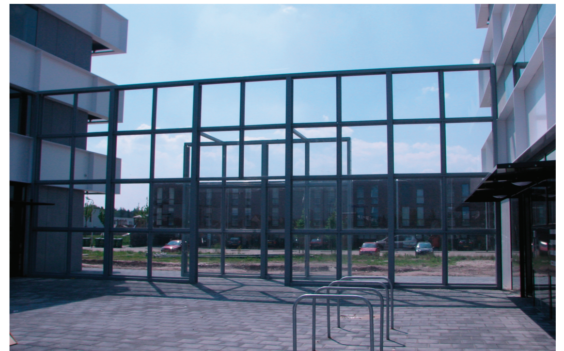
Foto: Stalen (met glasvulling) geluidsscherm
