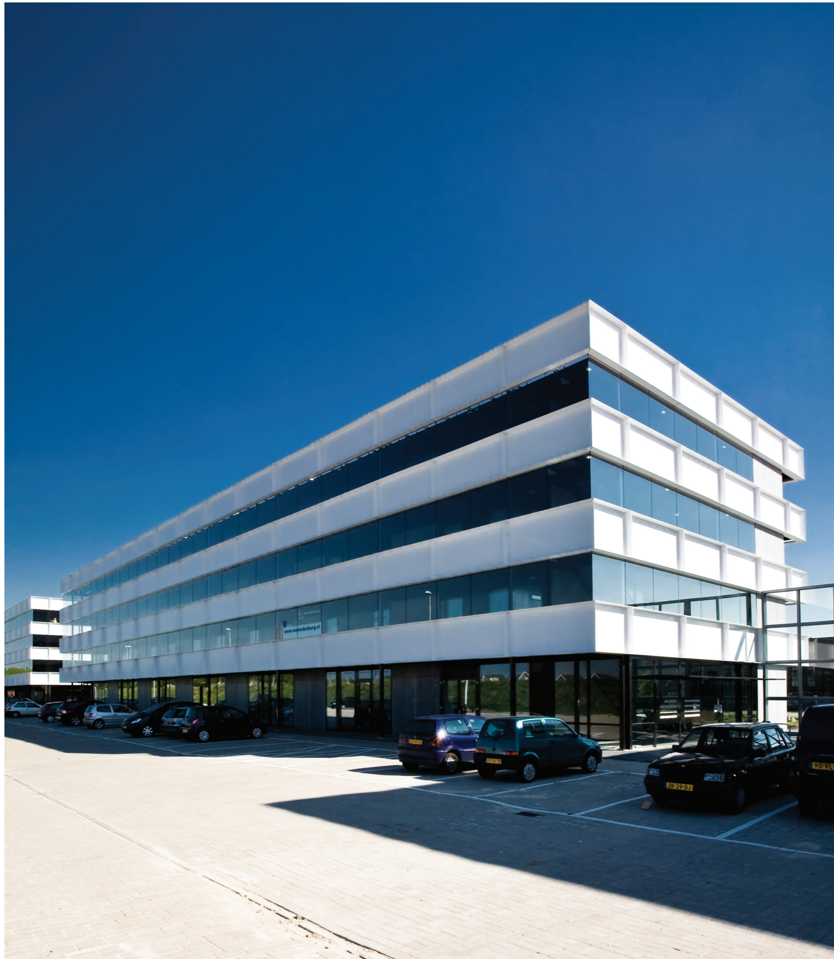
Foto: Gevel Noordzijde
