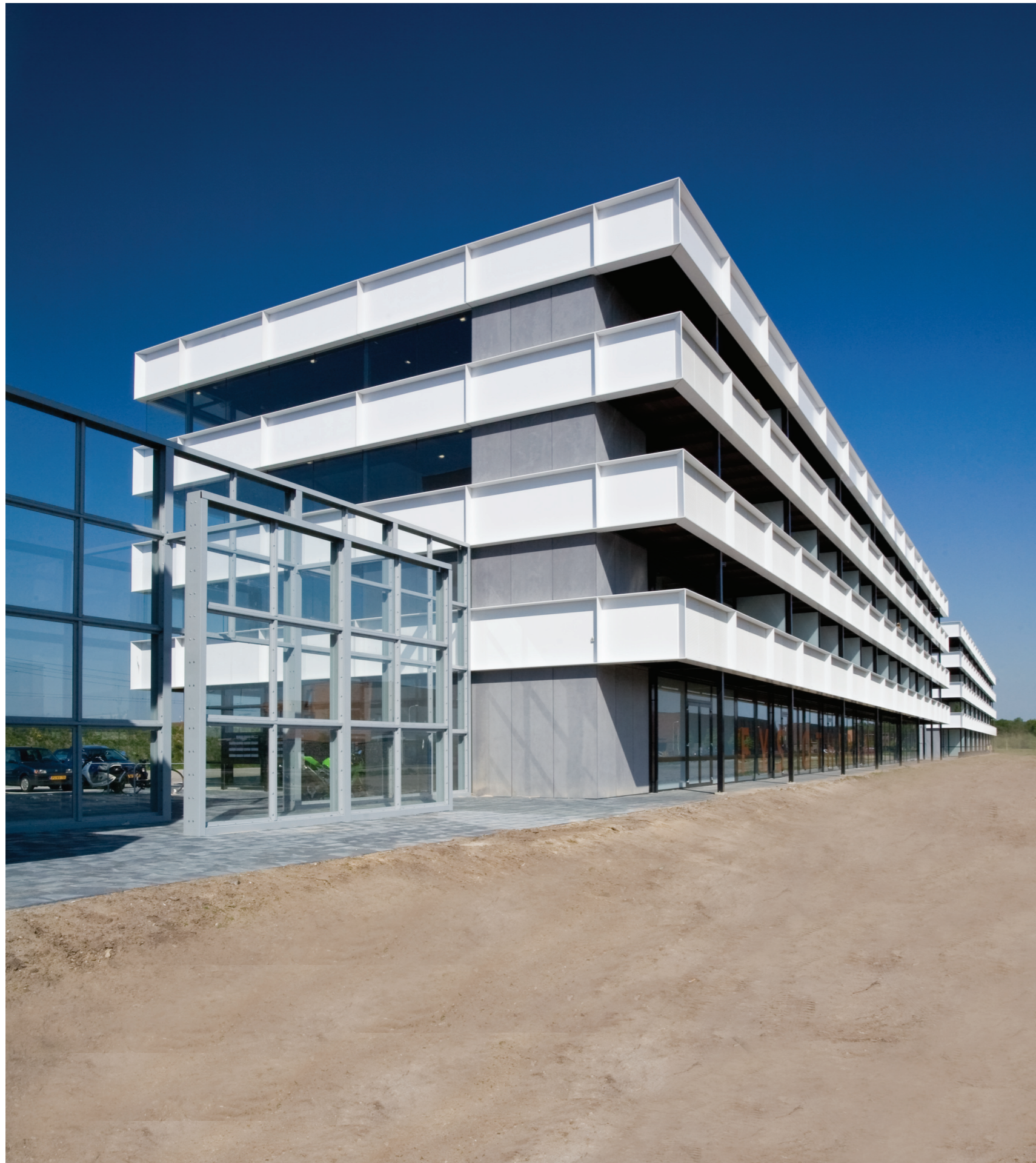
Foto: Gevel Westzijde
