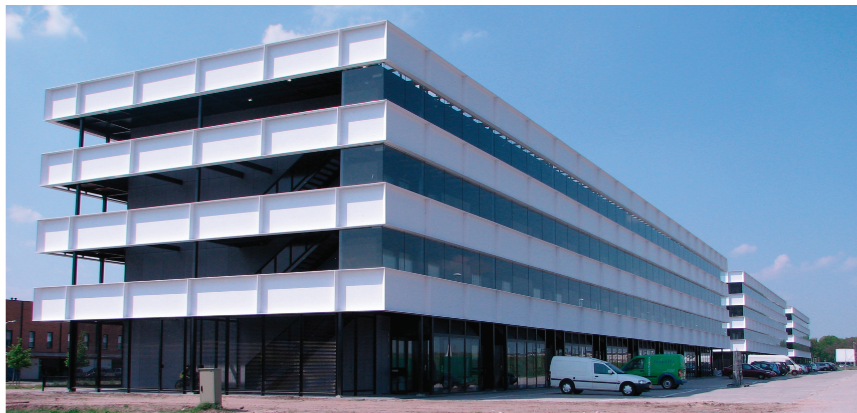
Foto: Gevel Noordzijde
