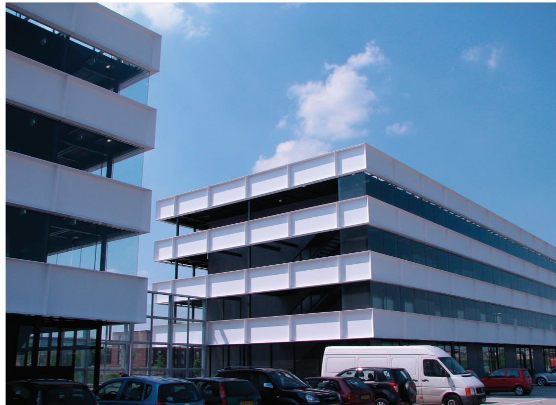
Foto: Gevel Noordzijde
