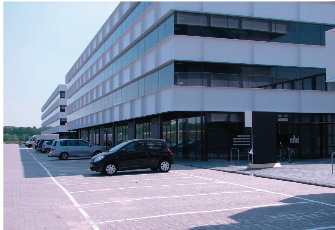
Foto: Gevel Noordzijde
