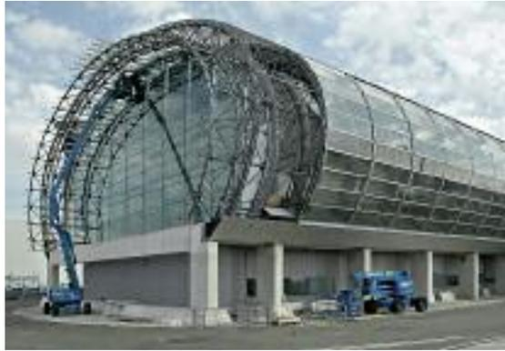
L'entraxe des arcs en treillis a été déterminé de manière à ce que les panneaux vitrés d'origine puissent être réutilisés.
