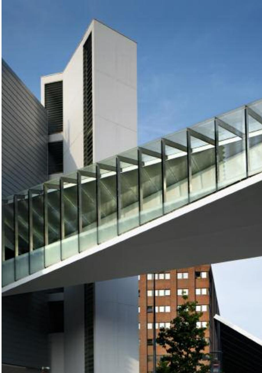
Les facettes de l'enveloppe résultent de l'imbrication diagonale d'éléments vitrés légers et de panneaux porteurs lisses en acier.
