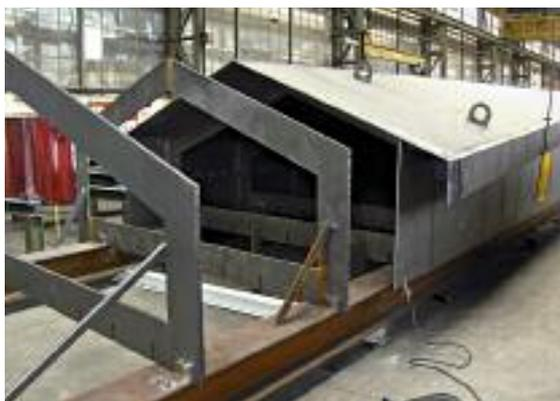
Réalisée dans une usine suisse, la passerelle a été transportée en trois parties à Liverpool, où un plan de montage très élaboré a permis de la mettre en place en une nuit.
