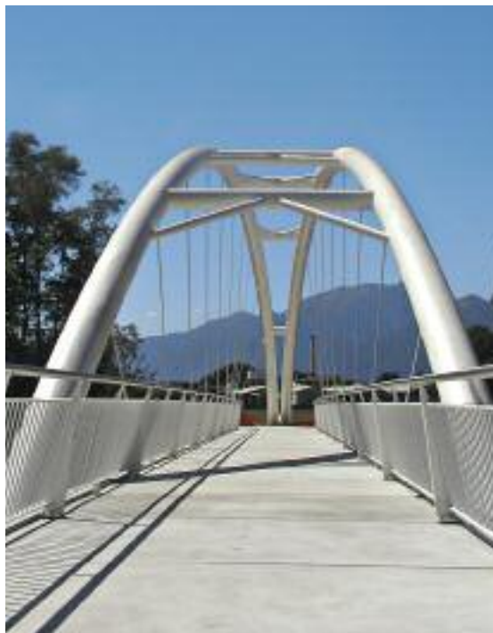
Die beiden parallel geführten Bögen sind leicht zueinander geneigt, spannen sich im Mittelfeld der Brücke auf und laufen am Ende wieder zusammen.
