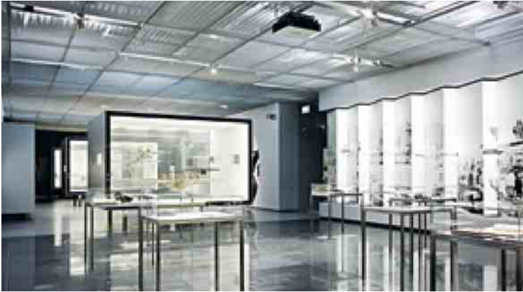
Auch in den Räumen der Ausstellungsbox ist die Tragkonstruktion in Form von Stahlträgerrosten in der Decke erkennbar.
