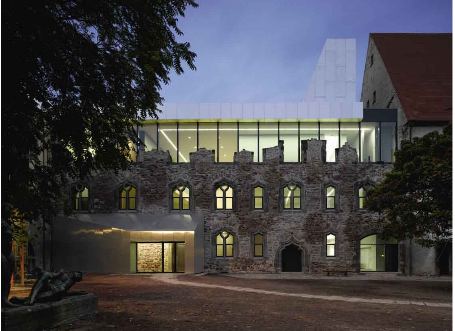
Die leichte, bewegte Dachlandschaft hebt sich deutlich von den Mauern der Burgruine ab. Die Beleuchtung verdeutlicht die Schnittlinie zwischen Alt und Neu.
