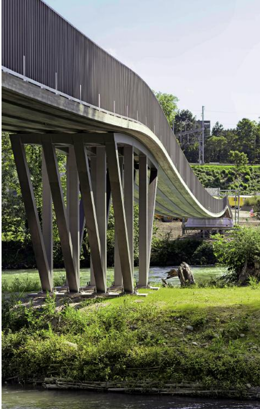
Les appuis n'empiètent pas sur le cours d'eau et respectent le caractère de l'île.
