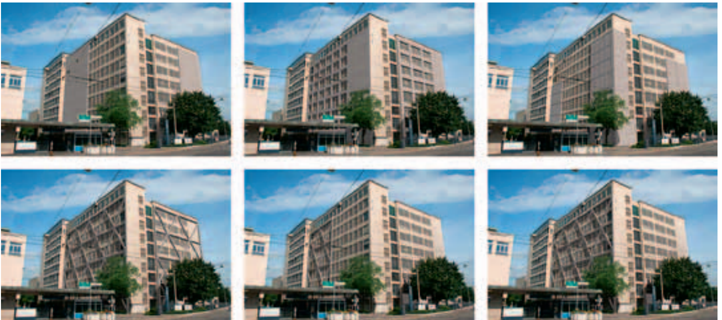
Gebäude K-90 der Firma Huntsman in Basel nach Fertigstellung der Erdbebenertüchtigung.
