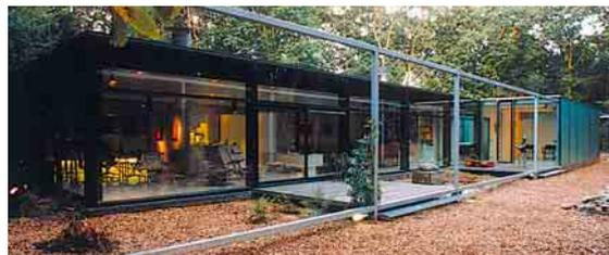
**Sur une parcelle boisée s'élève à Epe, au Pays-Bas, cette boîte à habiter abstraite destinée à un collectionneur d'art. L'extension par une structure en ossature d'acier contraste avec la maçonnerie de la maison réalisée dans les années 1970. Pourtant, la parenté entre les parties nouvelles et anciennes les fond en une nouvelle entité.**
