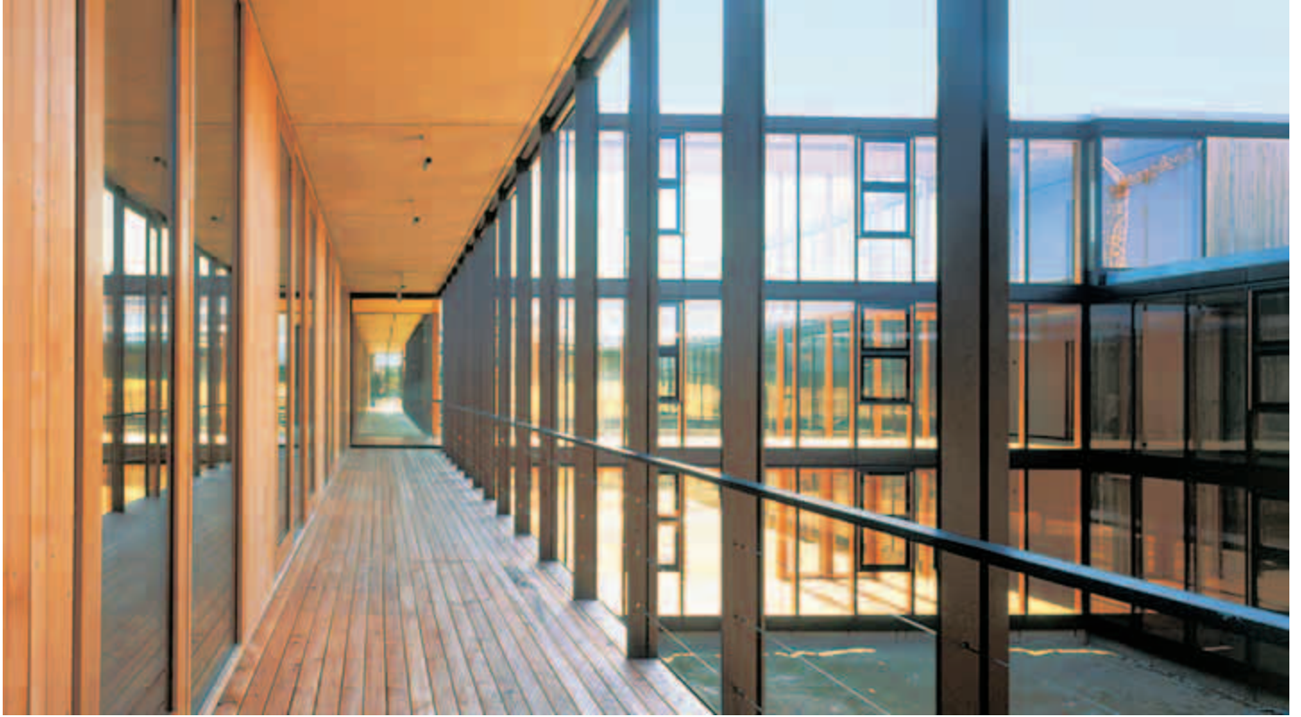
Die vorgelagerten Gänge sind Erschliessungszone und Holzschutz zugleich.
