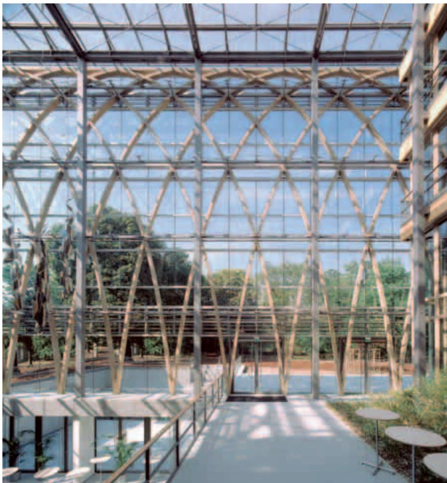
La structure en acier élancée et les arcs en bois lamellé-collé de la façade se complètent pour former un entrelacs d'une grande qualité plastique.
