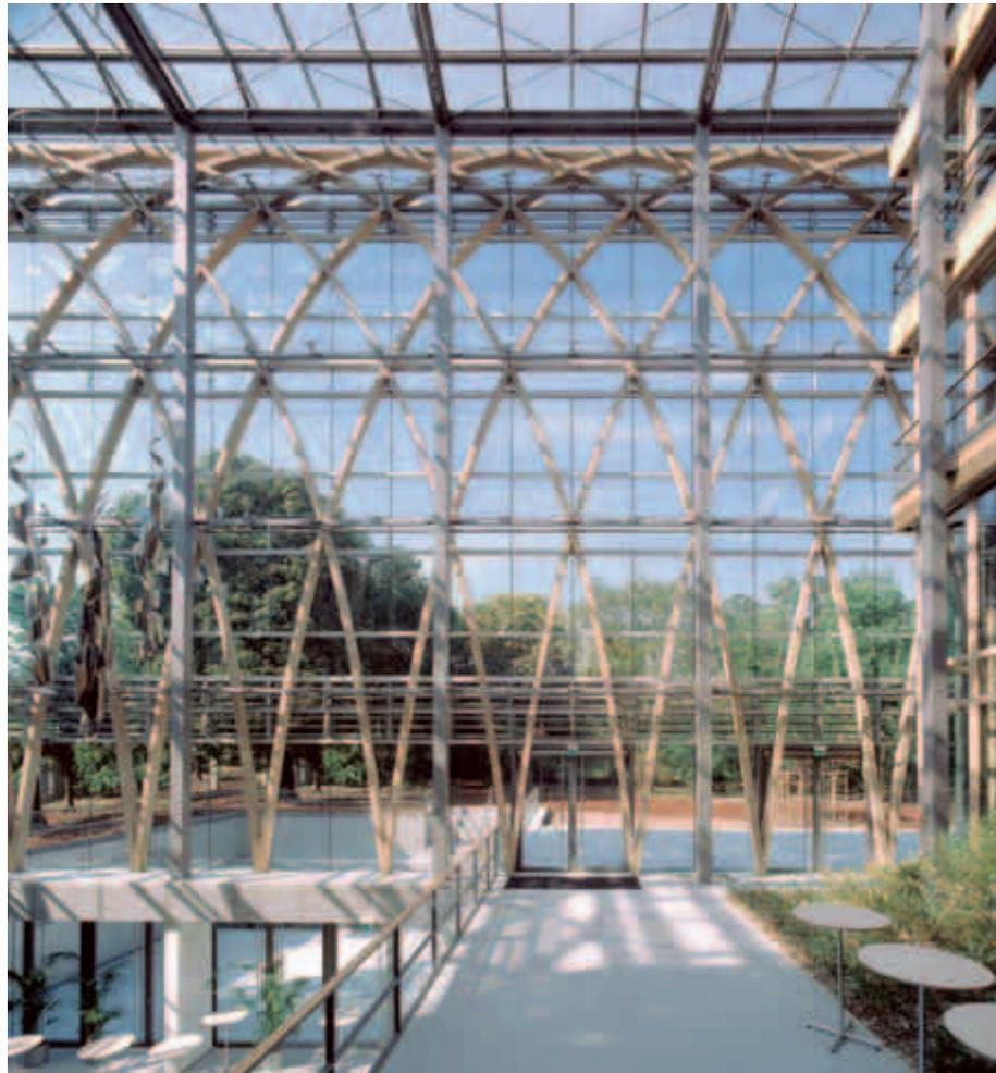
Die filigrane Stahlkonstruktion und die gebogenen Brettschichtholzträger ergänzen sich zu einem Geflecht von sinnlicher Qualität.
