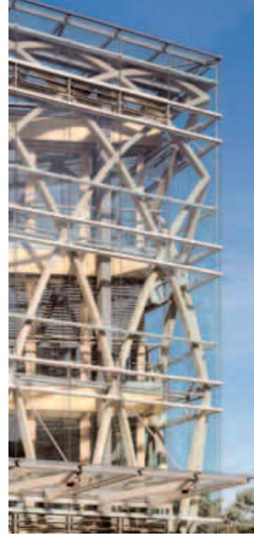
Die Holzkonstruktion verdichtet sich durch die flachere Neigung der parabelförmigen Träger
