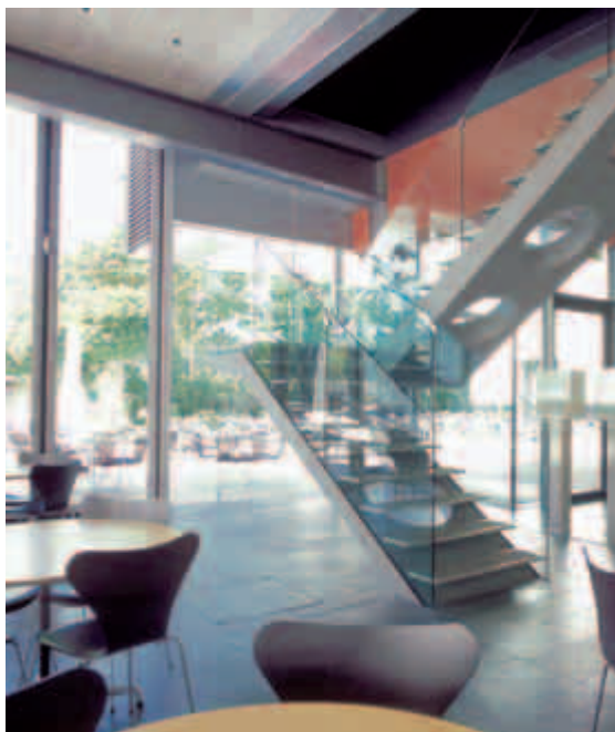
Entrée du restaurant. Un escalier en acier soudé mène aux toilettes aménagées au niveau supérieur où se trouvent également les installations techniques.
